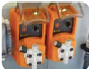
Pompe dosatrici per additivi di pre-trattamento
